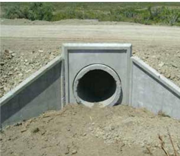
Imagen 23: Cabeceras de hormigón premoldeado.
