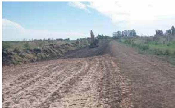
Imagen 5: Conformación de caminos.. Extracción de capa vegetal. Obtención de subrasante firme y estable. Conformación de camino en capas.
