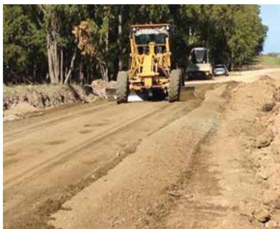
Imagen 18: Proceso de estabilizado de un material granular de baja calidad.
