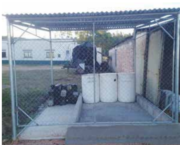
Figura 19: Almacenamiento adecuado de aceites y residuos mecánicos.
